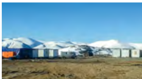
БМУ ГЭМ строит «под ключ» подстанцию в Забайкальском крае → стр. 3
