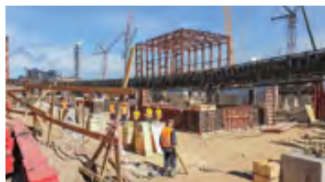
КЭМ выполняет работы по заказу ПАО «Северсталь» → стр. 5
