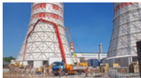
ПЭС сооружает градирню № 3 на Челябинской ГРЭС → стр. 5
