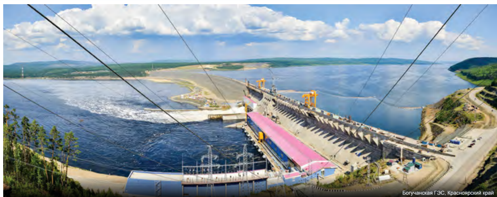
Богучанская ГЭС, Красноярский край
