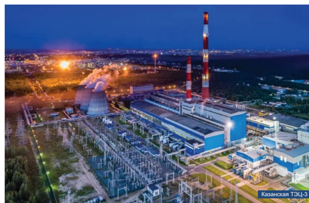
ПС 110 кВ «Прикамская», г. Елабуга
